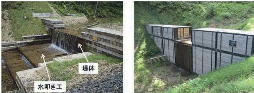
図2 オールウッド型木製治山ダム (左) とハイブリッド型木製治山ダム (右)
