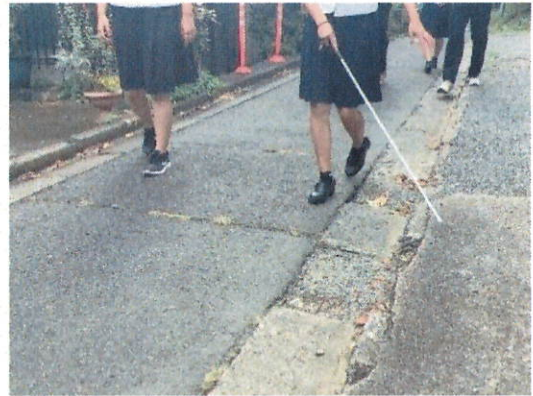
写真9 (舗装されていない道)
